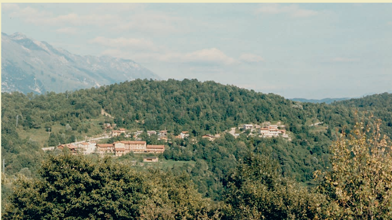
LE CASE DI FLAIPANO REALIZZATE DAI CLAPS FURLANS DURANTE LA COSTRUZIONE E DOPO LA CONCLUSIONE DEI LAVORI ACCANTO AL TITOLO: L'ING. GAETANO COLA, ALL'EPOCA DIRETTORE DELL'ASSOCIAZIONE INDUSTRIALI DI UDINE (CHE FINANZIÒ LA RICOSTRUZIONE DI FLAIPANO), VISITA IL CANTIERE ACCOMPAGNATO DAL PRESIDENTE DEI CLAPS
